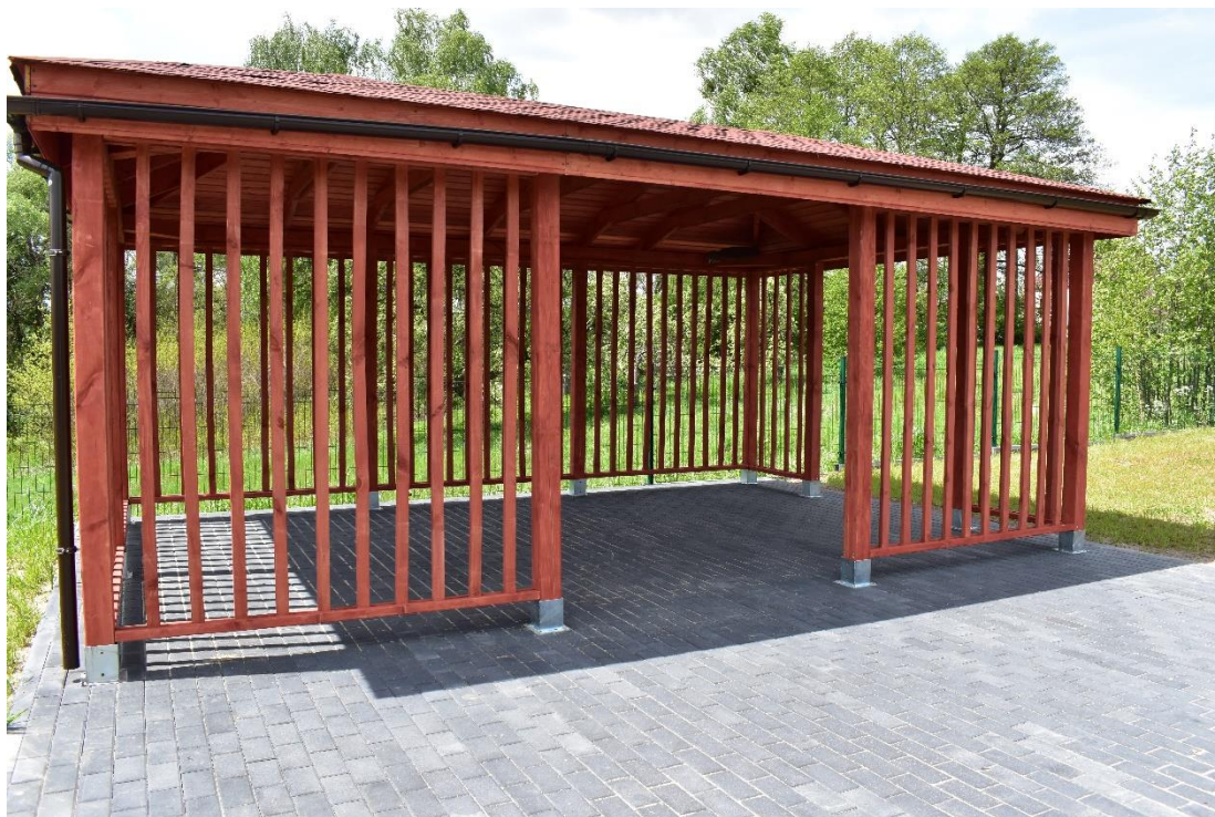
Wykonanie altany oraz utwardzenie terenu poprzez wyłożenie kostką brukową w sołectwie Szarlejka
