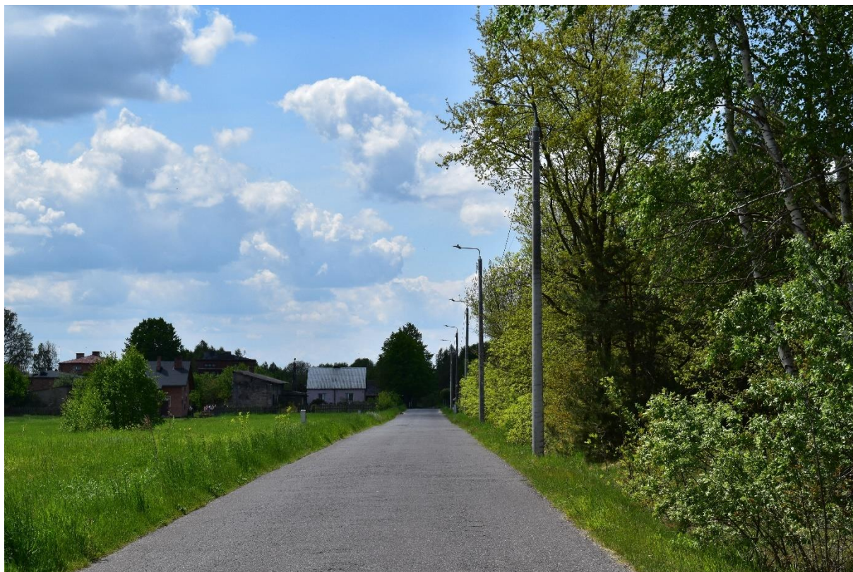
Budowa oświetlenia ulicznego w pasie drogi gminnej w sołectwie Klepaczka
