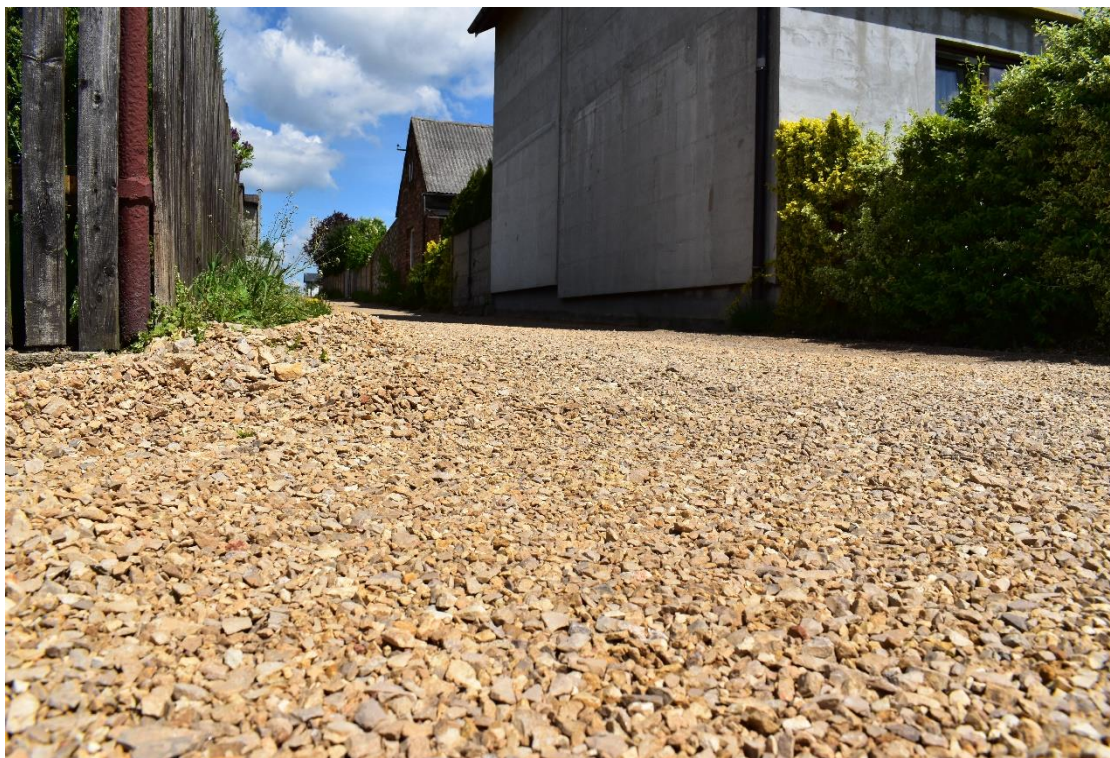
Budowa drogi wewnętrznej ul. Św. Józefa w Pile Drugiej
