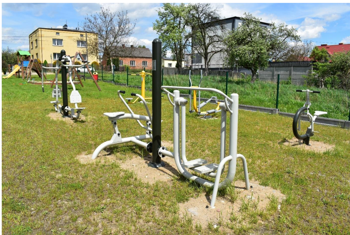
Budowa siłowni napowietrznej w Szarlejce
