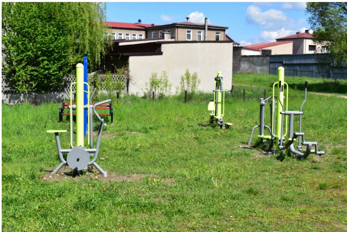
Budowa siłowni napowietrznej w Truskolasach
