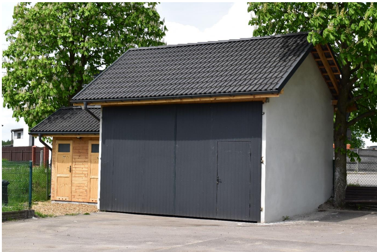
Remont budynków w sołectwie Puszczew
