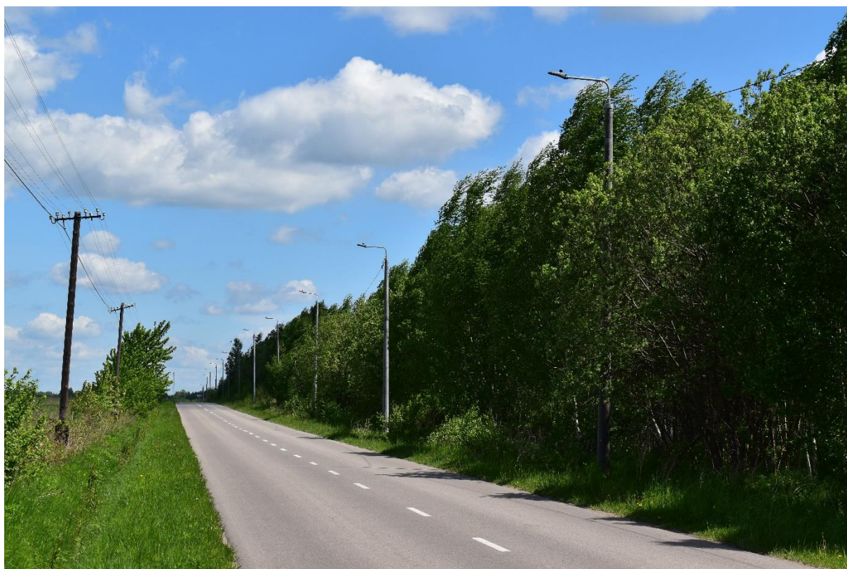
Budowa oświetlenia ulicznego w pasie drogi powiatowej Brzezinki -Zamłynie
