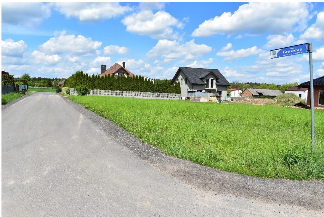
Przebudowa ulicy Gruszowej we Wręczyca Wielkiej
