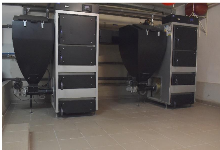
Modernizacja kotłowni w szkole w Kalei
