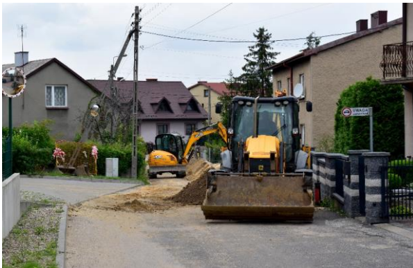
Przebudowa ul. Strażackiej we Wręczyca Wielkiej
