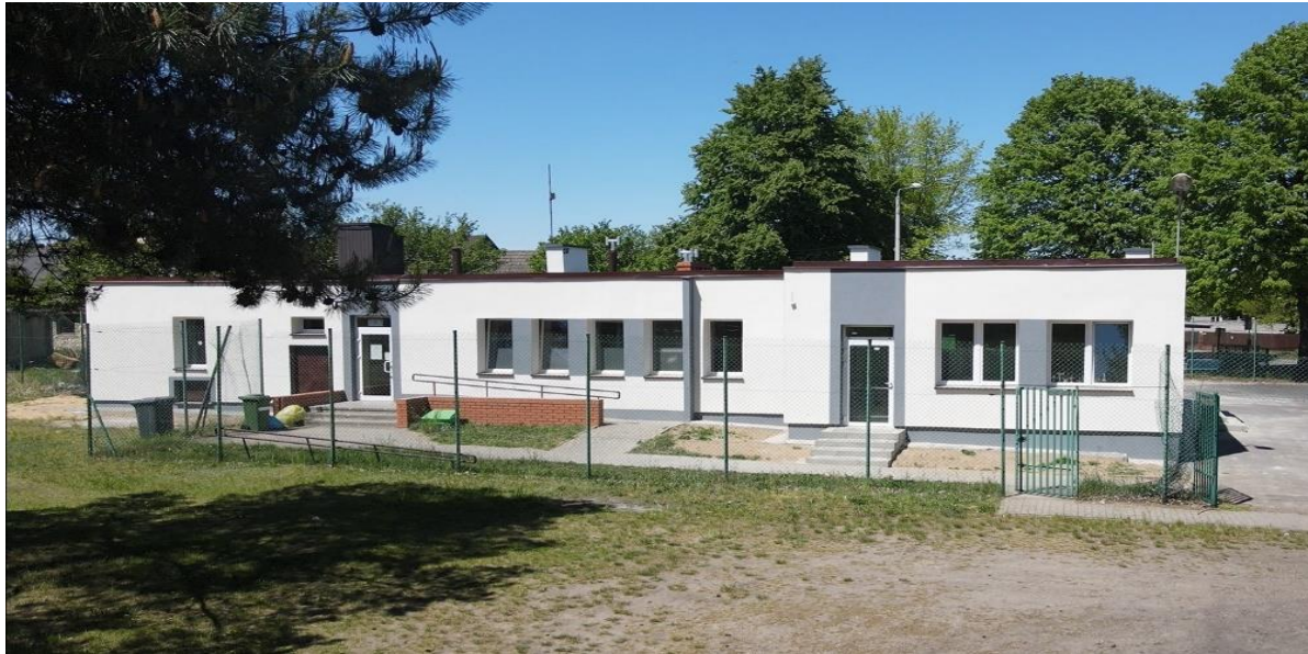
Wyremontowany budynek w Golcach
