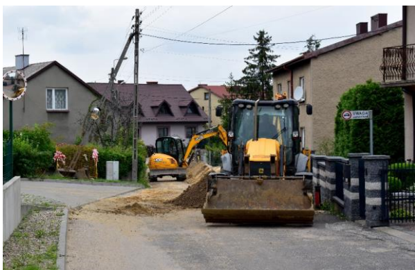
Przebudowa ul. Strażackiej we Wręczyca Wielkiej
